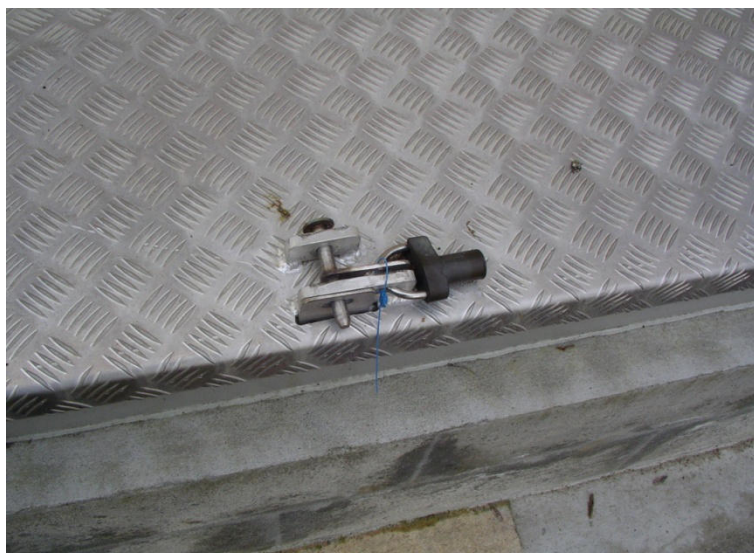
Trappe avec scellé
