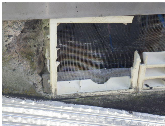
Ventilation en plastique et toile moustiquaire peu résistantes
