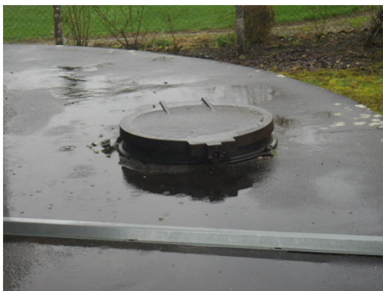
Trappe fermée avec une clef « triangle » non sécuritaire
