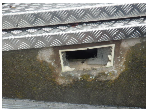
Ventilation en plastique et toile moustiquaire peu résistantes
