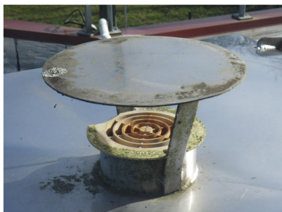
Ventilation en plastique peu résistante
